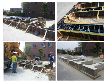
사진 2. 고로슬래그 치환에 의한 실부재 타설
